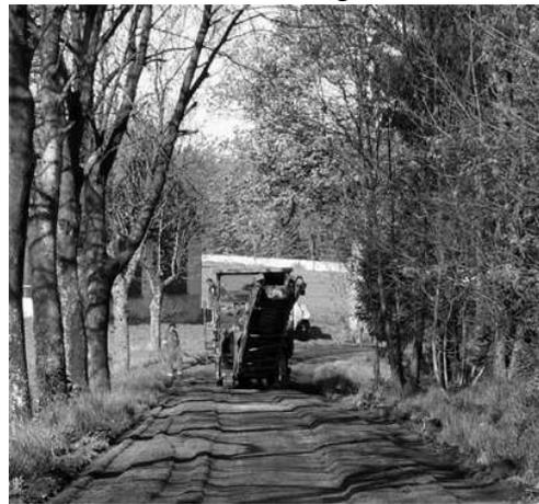
Verstärkung des Unterbaues an Ort und Stelle geblieben. Mittels Grader wurde das Fräsmaterial eingeebnet und anschließend mit einer Walze verdichtet. Nach zwei Wochen ist ein 8 cm starker Straßenbelag aufgebracht worden.
