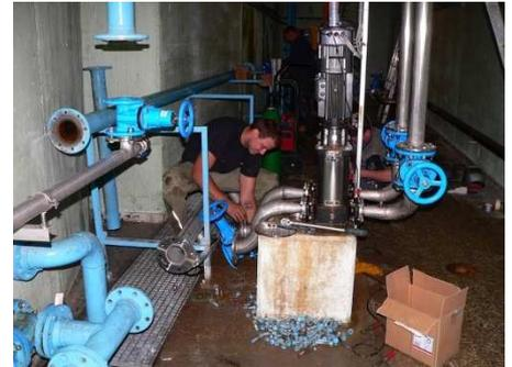
Im Zuge dessen wird eine neue, drehzahlgesteuerte Pumpe für den Feuerlöschfall eingebaut. Während der Sanierungsphase der jüngeren und größeren Behälter, erfolgt die Wasserversorgung über die zwei älteren Behälter. In der Umschaltphase musste die Wasserversorgung für einige Stunden unterbrochen werden. Bei der Wiederinbetriebnahme der sanierten Behälter wird es noch einmal zu einer kurzen Unterbrechung der Wasserversorgung kommen.
